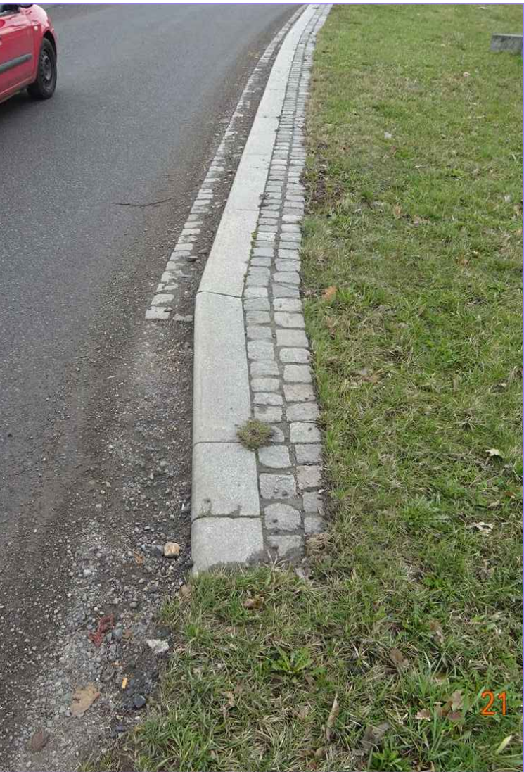
DETAIL PROVEDENÍ OBRUBY VČETNĚ MASIVNÍ BOČNÍ OPĚRY
